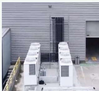
STEMCELL Technologies, et globalt bioteknologisk firma, installerede CO 2 -kondenseringsenheder – CR-serien til kølerum på lageret. Frankrig. Køling
