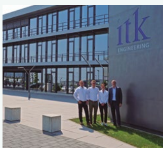
ITK Engineering GmbH. En innovativ kontorbygning i Tyskland. ECOi - PACi
