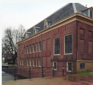
En historisk bygning på Amsterdams Marineterrein. Holland. ECOi-W
